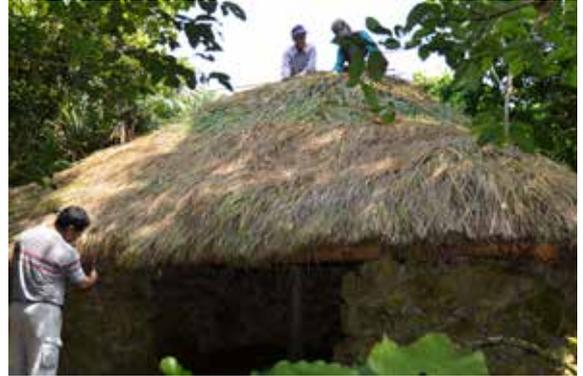
写真 平成27(2015)年時のウイウスムトゥの屋根の茅葺き替え工事風景
