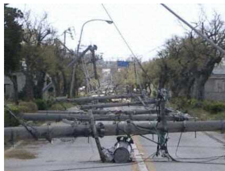
図：台風 14 号によって道路に倒れた電柱(宮古島市)
