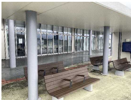
図：バス停上屋の設置例(宮古島市役所)
