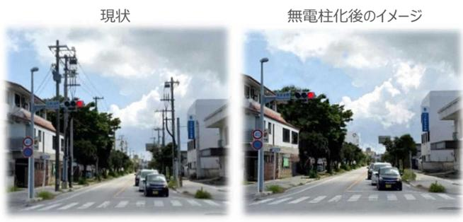
図：無電柱化後のイメージ(宮古島市中央縦線)
