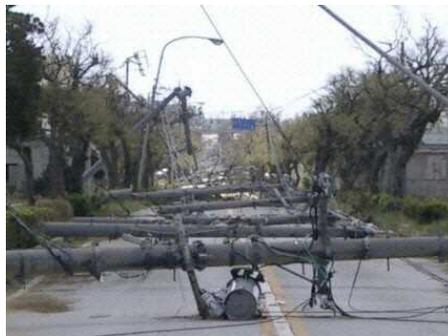
図:台風 14 号によって道路に倒れた電柱(宮古島市)
