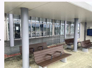
▲バス停上屋の設置例(宮古島市役所)
