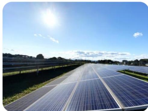
【メリット】太陽光が当たれば電力を生み出してくれる発電方法。燃料を必要としないので、排気ガスやCO2、燃えかす、使用済み燃料の処理なども発生しない。稼働部分がないため、故障が発生しにくく信頼性が高い。
