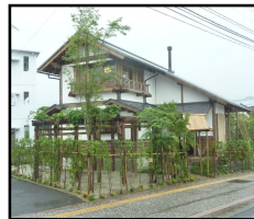
水俣市エコハウス外観
